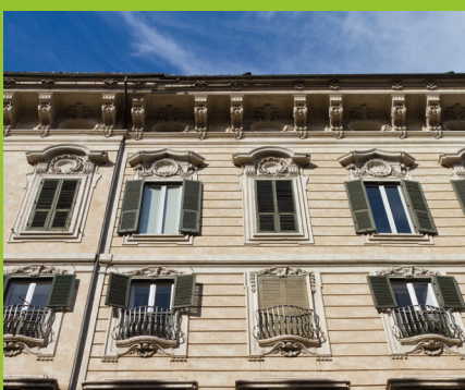
Renowacje i modernizacje budynków (w tym zabytkowych)
