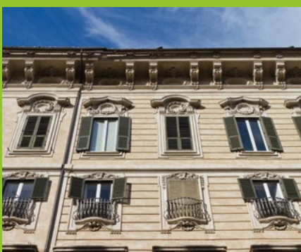
Renowacje i modernizacje budynków (w tym zabytkowych)
