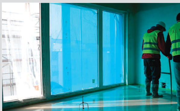
Wykończenie powierzchni podkładu anhydrytowego przez sztangowanie
