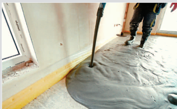
Układanie mineralnej piany AIRIUM na osiedlu budynków wielorodzinnych w Poznaniu. Materiał na miejsce wbudowania dostarczany był za pomocą pompy
