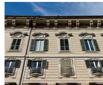
Renowacje i modernizacje budynków (w tym zabytkowych)
